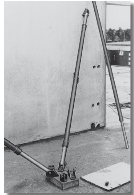
Grote bewegingsvrijheid, onder elke willekeurige hoek, bij toepassing van slechts één bout.
