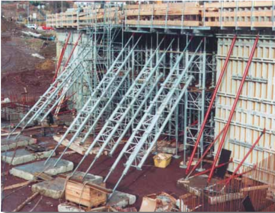
Plaatsing van knikverkorters door knikramen en/of schoorstempels.
