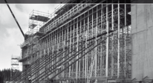
Bekisting en ondersteuning
