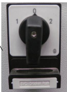
Figuur 11 faseomkeerschakelaar
